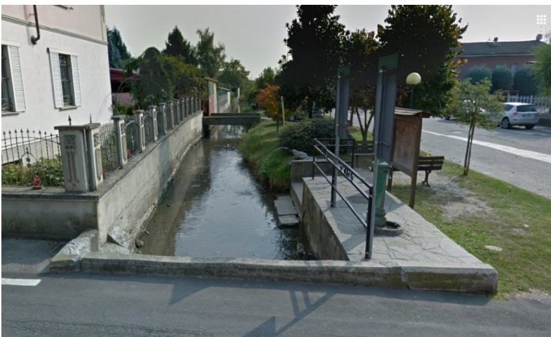
La Biraghetta prima della realizzazione del nuovo parapetto.
